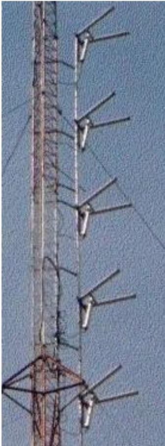
La serie de antenas de banda ancha soldadas "LDY" esta formada por dipolos horizontales, en forma de "Y" conectados en fase. Con estas antenas se puede obtener **diagramas de irradiación omnidireccionales en polarización horizontal, con muy buena circularidad.**
